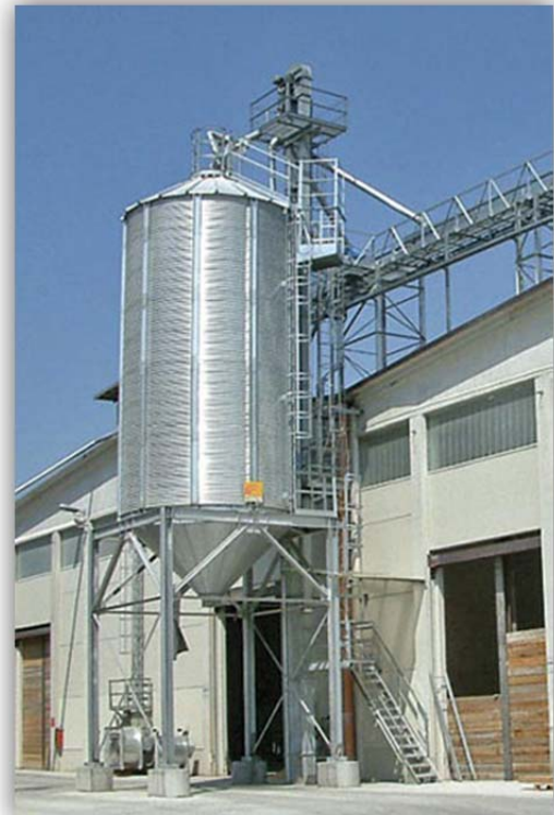
Fig. 21. Silo de carga rápida
