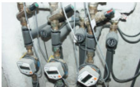
Contadores individuales de energía de calefacción, válvulas de zona y válvulas de equilibrado por vivienda.
