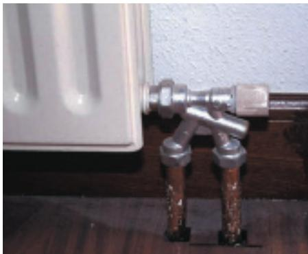
Radiador con conexión monotubo, con llave de corte que incorpora el detentor de reglaje.
