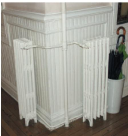
Radiadores de hierro fundido de una instalación con distribución por montantes; únicamente disponen de llave de corte en la entrada.
