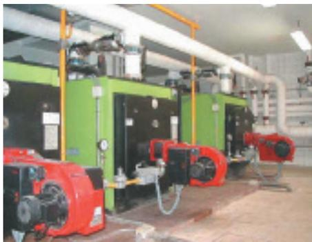
Calderas pirotubulares con quemadores mecánicos a gas
