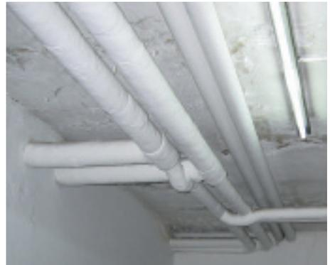
Distribución general de calefacción única, sin llaves de corte en cada ramal; la accesibilidad de la misma permite efectuar distribuciones independientes por orientaciones, además de poder instalar llaves de corte y de equilibrado en cada montante.
