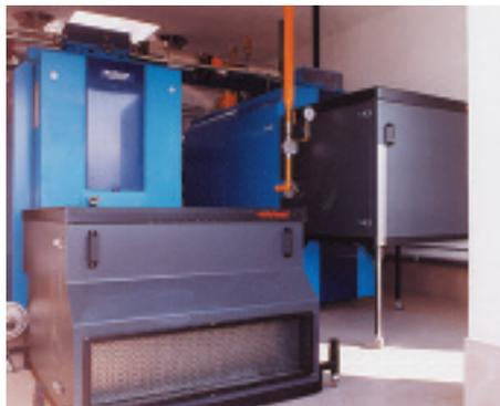
Calderas a gas de baja temperatura y condensación, con capós insonorizados para cubrir los quemadores.
