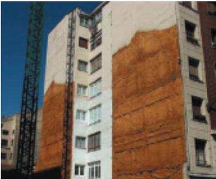
Aislamiento térmico proyectado sobre la fachada de un edificio tras la demolición del edificio contiguo.
