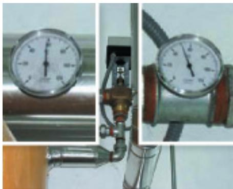
Regulación de la temperatura de distribución de ACS; la temperatura del acumulador es de 60°C, mientras que la distribución se efectúa a 50°C.
