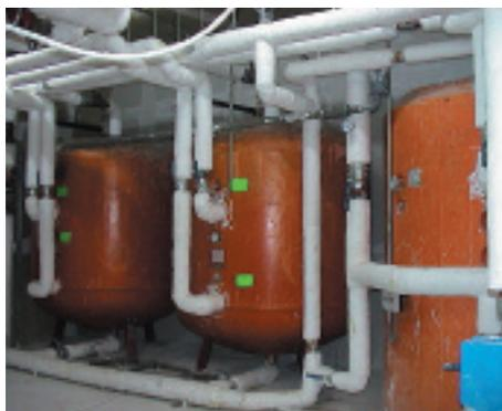
Producción central de ACS con depósitos calentados por el sol y depósito calentado por las calderas.
