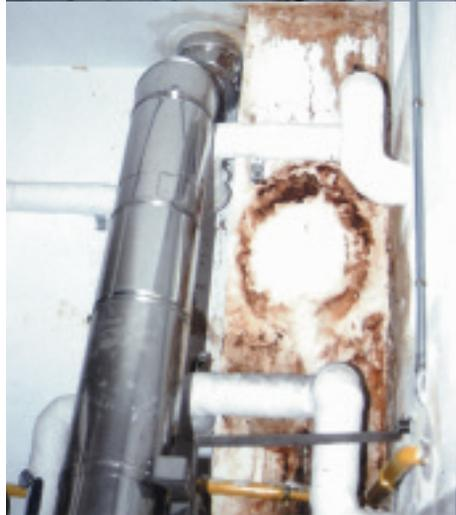
Sustitución de chimenea de obra por una chimenea modular de doble pared de acero inoxidable con aislamiento térmico
