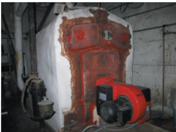
Caldera de carbón reutilizada para gasóleo; el rendimiento es muy inferior al que se alcanza con una caldera diseñada para el combustible seleccionado.
