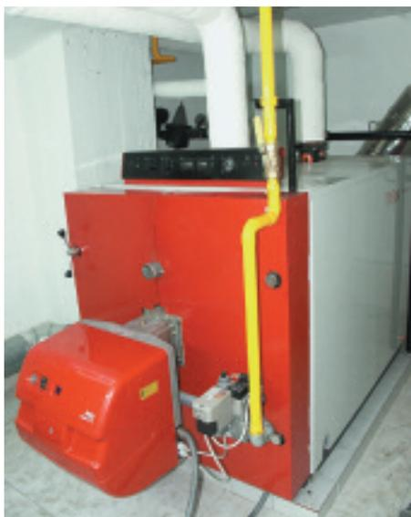
Caldera pirotubular con quemador mecánico a gas
