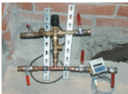
Elementos de control de la calefacción de una vivienda en una instalación central, durante su montaje en obra.
