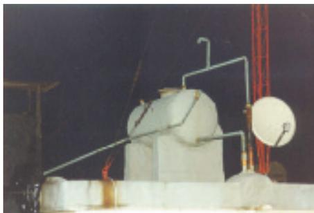
Vaso de expansión abierto de una instalación de calefacción central, situado en la cubierta del edificio.
