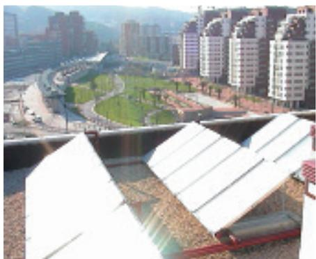
Captadores solares térmicos para producción de ACS central en un edificio de viviendas.
