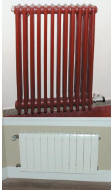
Existen distintos tipos de radiadores de calefacción. Según el material con el que han sido fabricados: hierro fundido, aluminio, chapa de acero, tubos de acero; y según su forma constructiva: panel, elementos.
