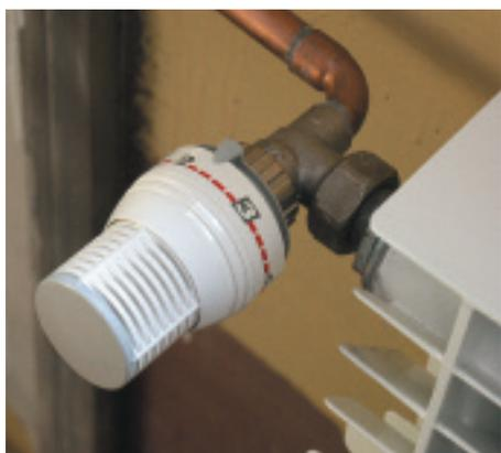
Válvula termostática en radiador con distribución bitubo.
