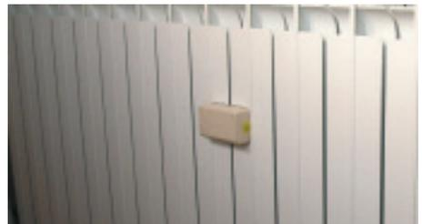
Evaporímetro para medición del consumo de calefacción individual.
