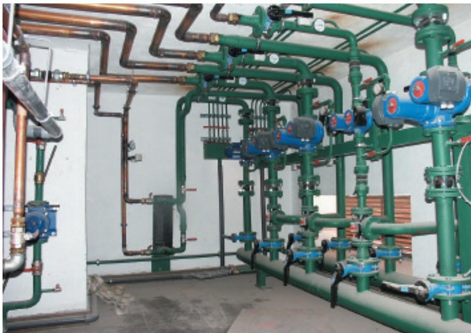
Edificio con regulaciones de calefacción según usos y orientaciones. Instalación en fase de montaje, antes de la colocación del aislamiento térmico de las tuberías y elementos.
