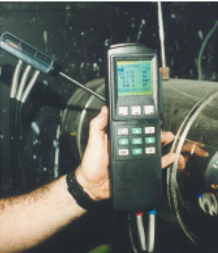
Comprobación del rendimiento de combustión del generador de calor.
